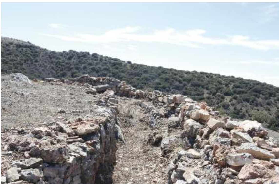
Trincheras del Portachuelo II, construidas con sendos muros de piedras areniscas
